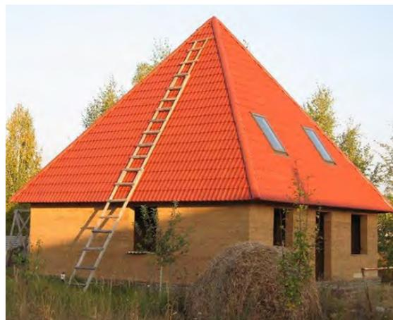
Рис. 73. Шатровая крыша
