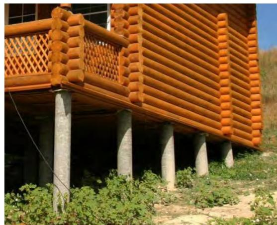
Рис. 50. Опоры столбчатого фундамента
