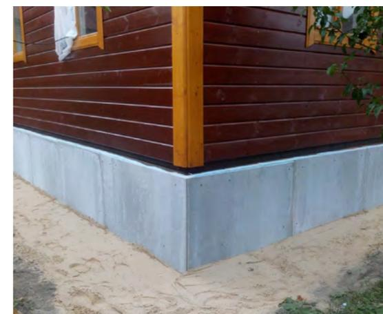
Рис. 124. Хризотилбетонный фундамент
