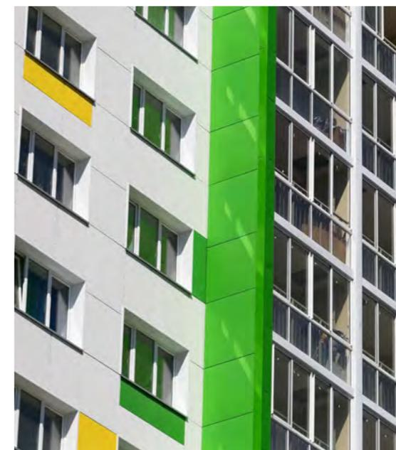
Рис. 16. Навесной вентилируемый фасад
