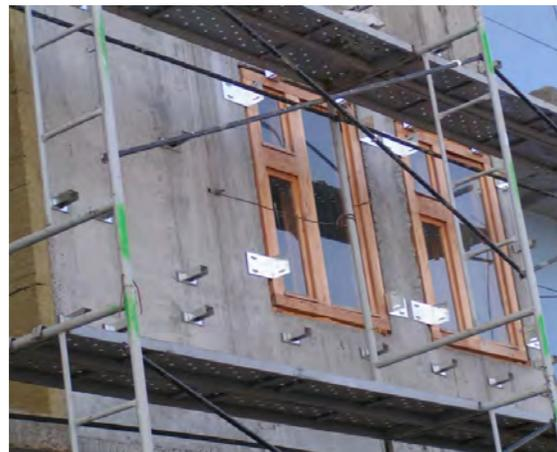
Рис. 117. Кронштейны несущего каркаса
