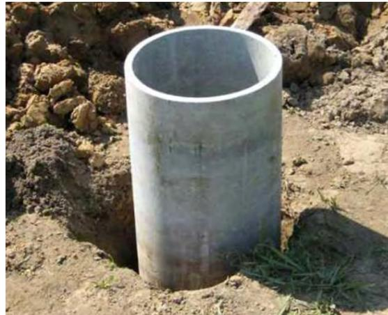
Рис. 48. Скважина из ХЦ трубы
