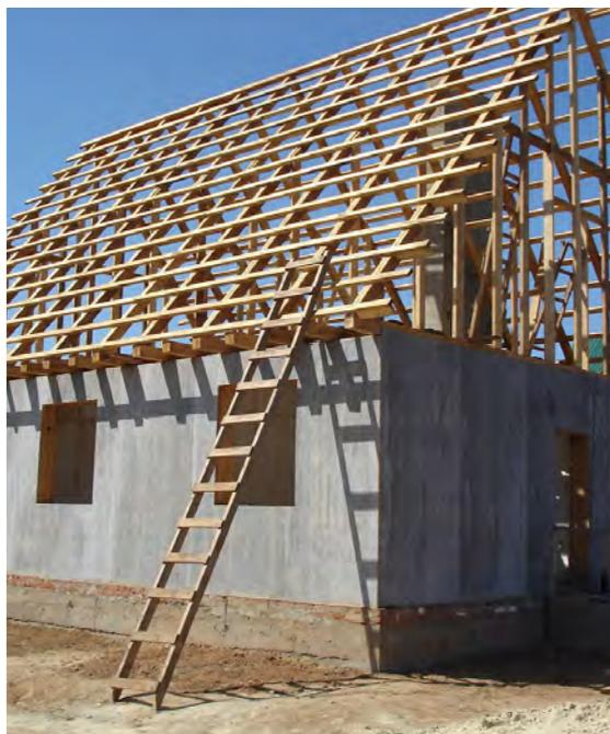
Рис. 128. Стены из ХЦ на деревянном каркасе
