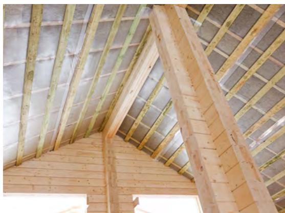
Рис. 63. Пароизоляционный слой
