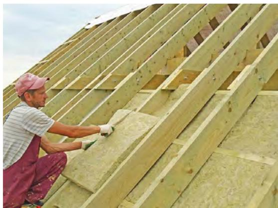
Рис. 62. Теплоизоляционный слой
