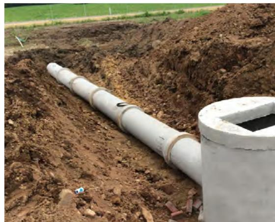
Рис. 23. Трубопровод из ХЦ труб
