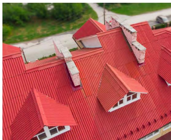
Рис. 74. Многощипцовая крыша
